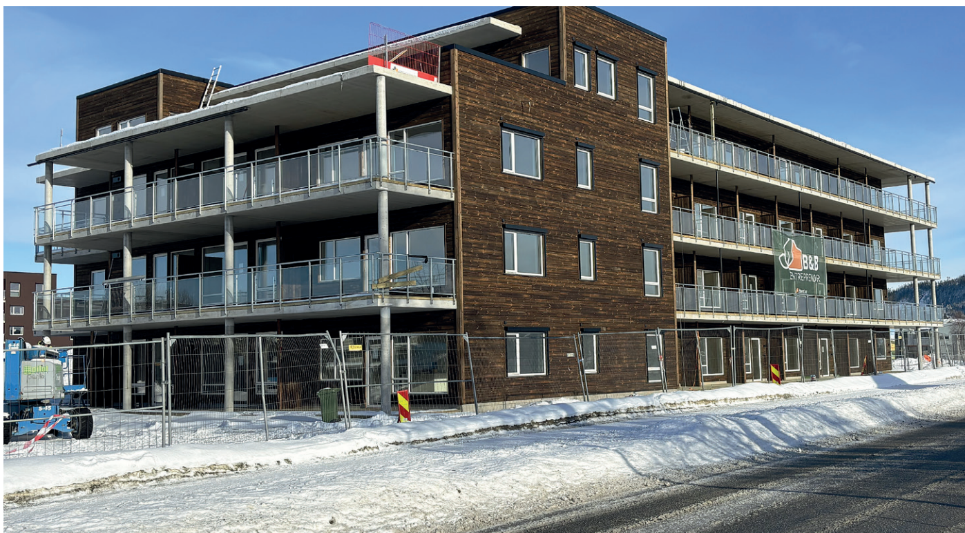
Fasaden med balkonger mot sør.
